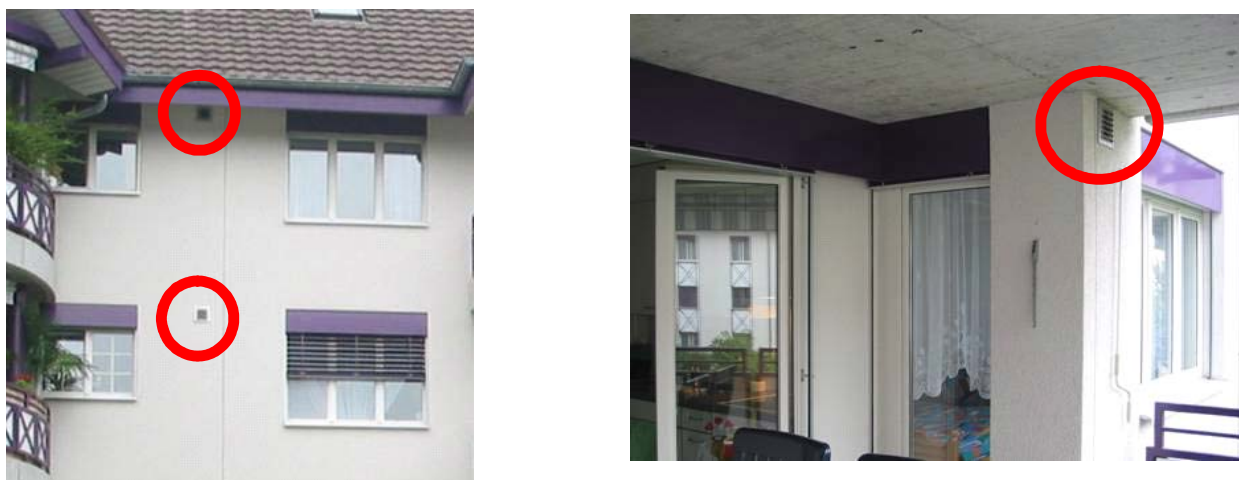
Figur 10: Küchenabluft kann je nach Wind in das eigene Fenster oder ans Fenster der Nachbarwohnung gelangen.
